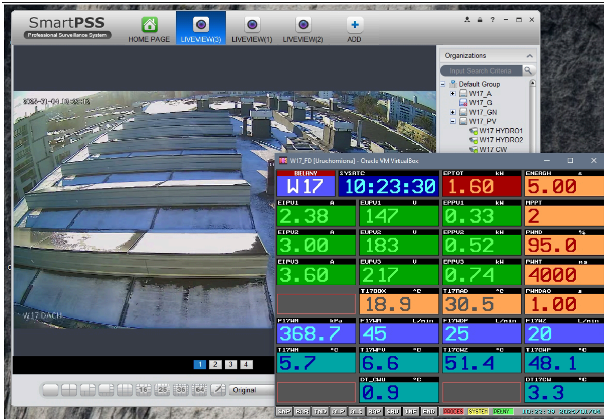
Abbildung 2. SCADA-System zur Überwachung der Photovoltaikanlage auf dem Dach
